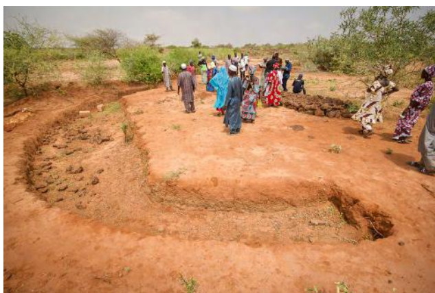
La demi-lune est une infrastructure anti-érosive communautaire construite dans le cadre du projet AgrobioNiayes mené par Enda Pronat à Keur Moussa.
