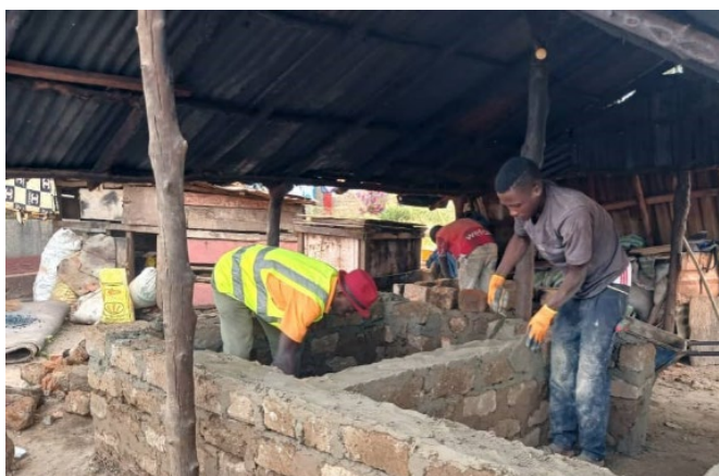
> Construction de fours à Kamsar
